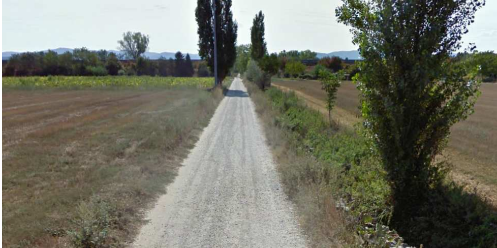
Fig. 3. Immagine della strada oggetto dell'intervento di adeguamento, a nord del rilevato stradale della E45, con vista verso il rilevato
