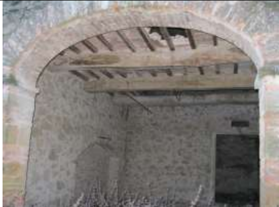
Particolare del piano terra dell'edificio n. 2 (fienile)
