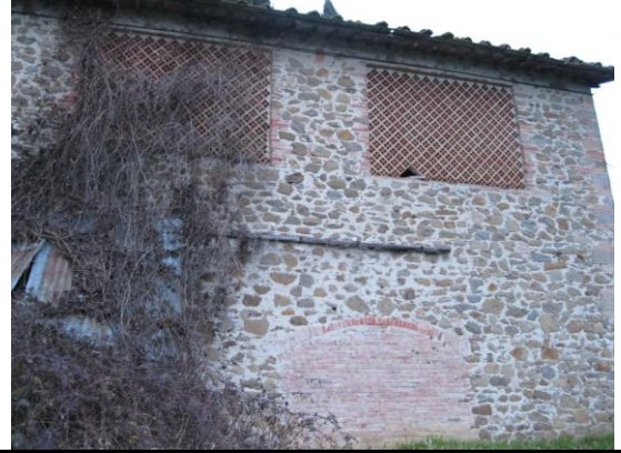
Il fronte sud dell'edificio n. 2 (fienile)
