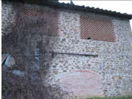
Il fronte sud dell'edificio n. 2 (fienile)
