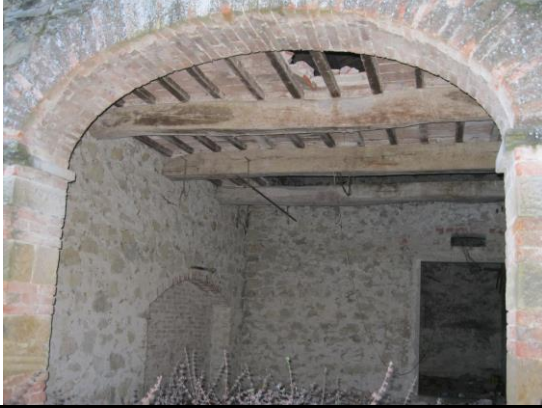
Particolare del piano terra dell'edificio n. 2 (fienile)
