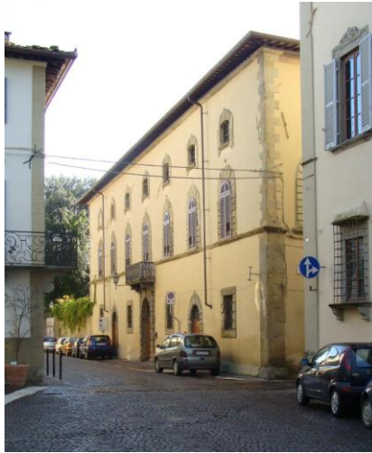
Fig. 1, Sansepolcro, Palazzo Collacchioni – facciata principale in via N. Aggiunti.
