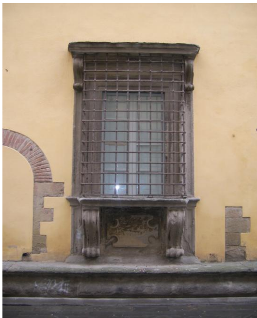
Fig. 80 Sansepolcro, Palazzo Ducci – Del Rosso – finestra del tipo “inginocchiato” al piano terra.
