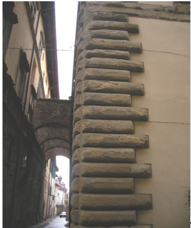
Fig. 77, 78 Sansepolcro, Palazzo Graziani – particolari del bugnato angolare in facciata.
