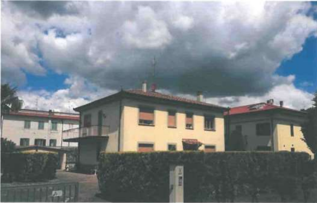
Foto 1 - Vista da via dei Fontesecca (interno).
