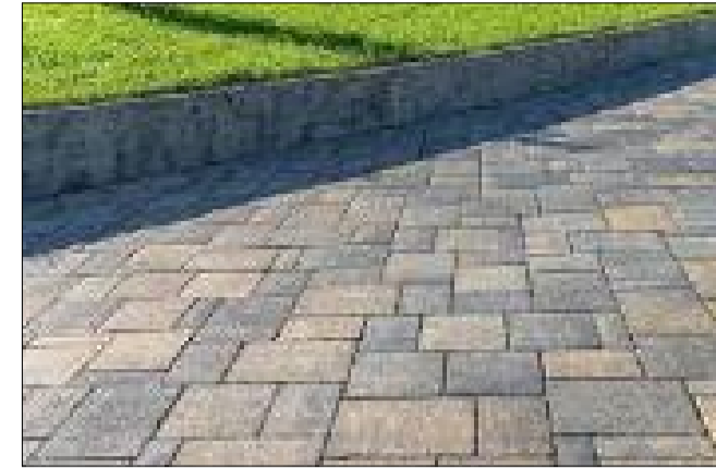
PAVIMENTAZIONE DRENANTE ELEMENTI AUTOBLOCCANTI
