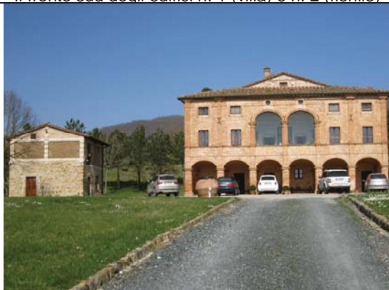
Il fronte sud dell'edificio n. 2 (fienile)
