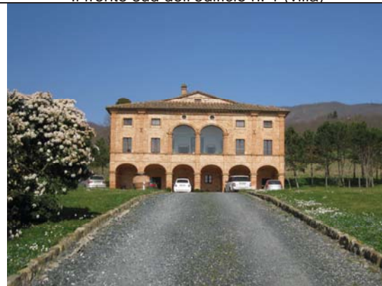
Il fronte sud dell'edificio n. 1 (villa)
