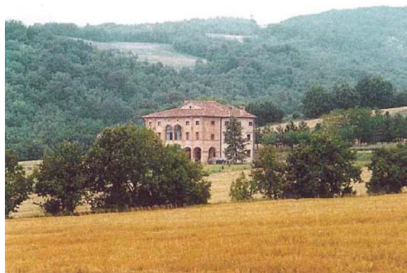
Il fronte sud dell'edificio n. 1 (villa)
