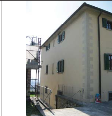
Il fronte est dell'edificio n. 1 (villa)
