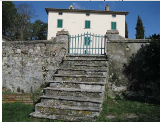
Il locale ricavato sul muro di cinta
