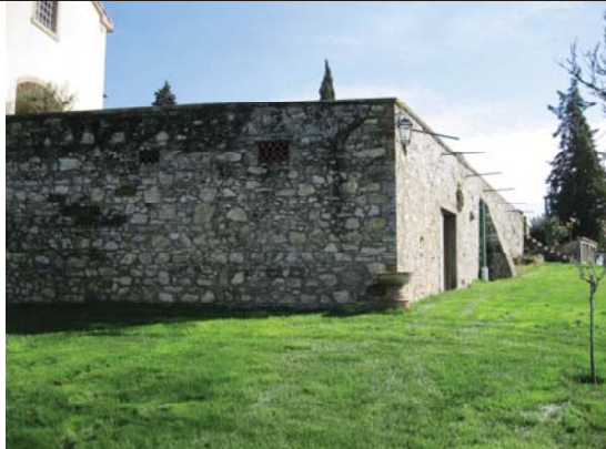
Vista dell'edificio n. 3 (cappella e annesso) dal giardino
