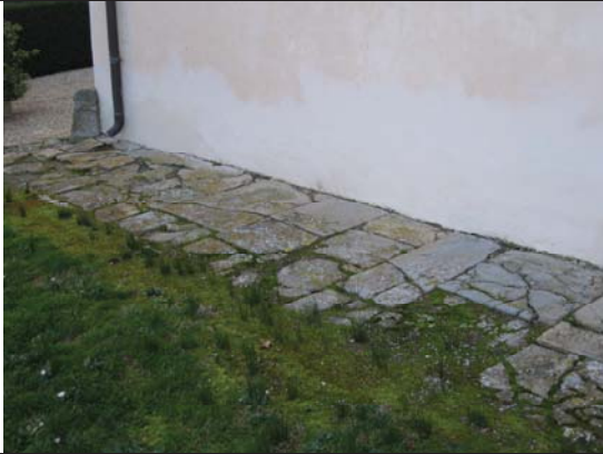
Vista dell'edificio n. 2 (pozzo)
