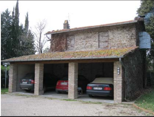
Il fronte dell'edificio n. 4 (garage)
