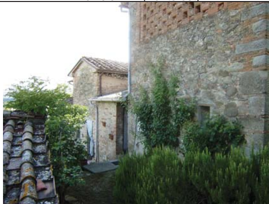
Edificio n. 3 (fronte ovest)
