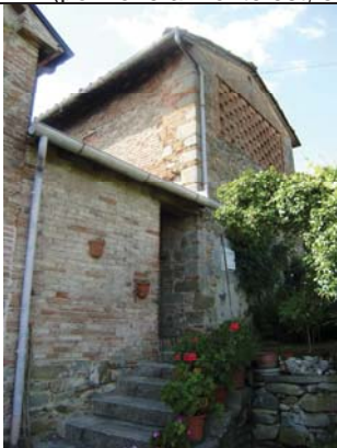
Edificio n. 2 (fronte nord)
