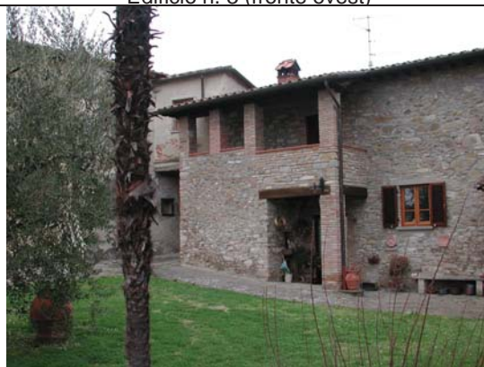
Edificio n. 3 (particolare fronte ovest)
