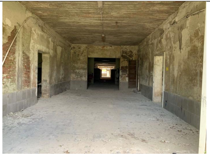
Scorcio del corridoio centrale al piano terra
