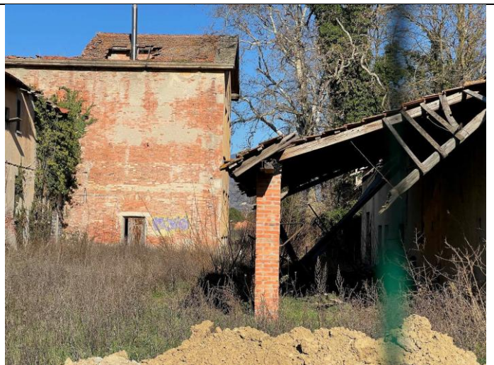
Foto 13 - Dettaglio dell'ala Sud-Est
