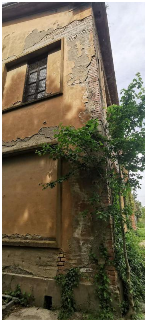
Foto 03 - Prospetto Sud-Est e scorcio Nord-Est
