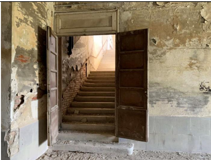
Scorcio del vano scala per accedere al piano primo
