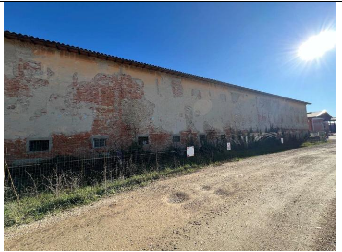
Foto 09 - Scorcio porzione del Prospetto Nord-Ovest
