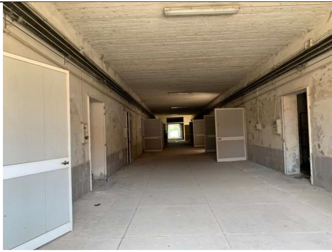
Scorcio del corridoio centrale al piano terra
