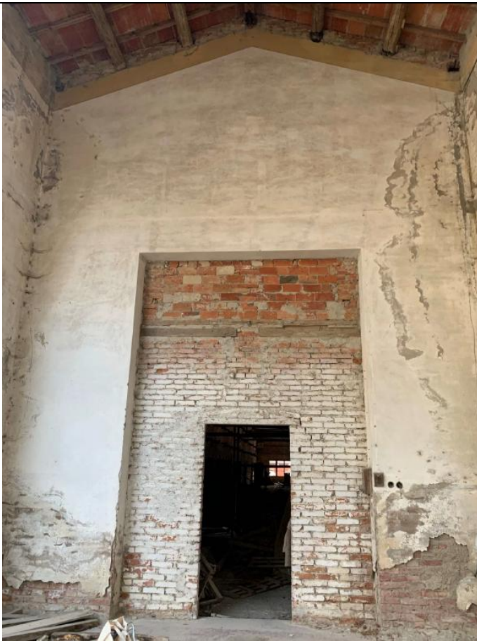
Scorcio della sala al piano primo_nord-ovest
