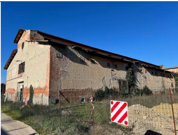
Foto 12 - Scorcio del fronte secondario Sud-Ovest e
