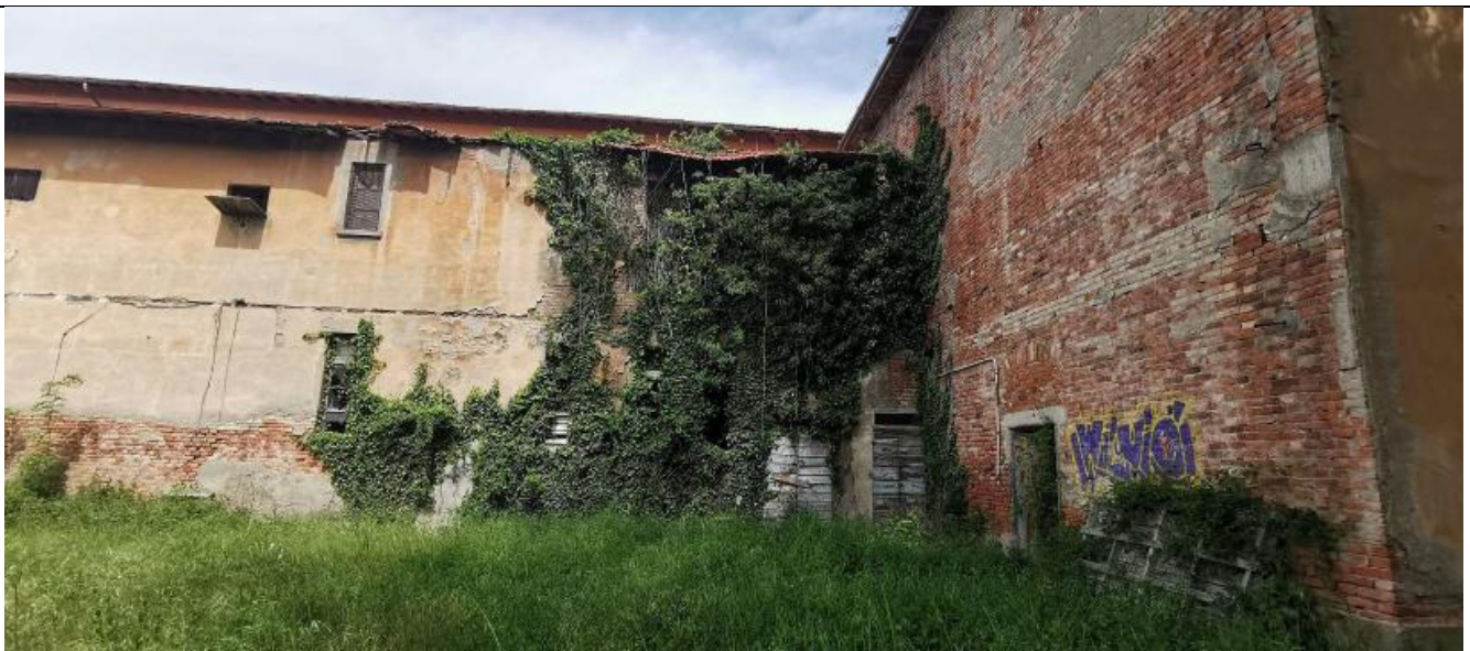
Foto 04 - Vista di parte del Prospetto Sud-Ovest e angolo con il retro dell'ala Nord-Est
