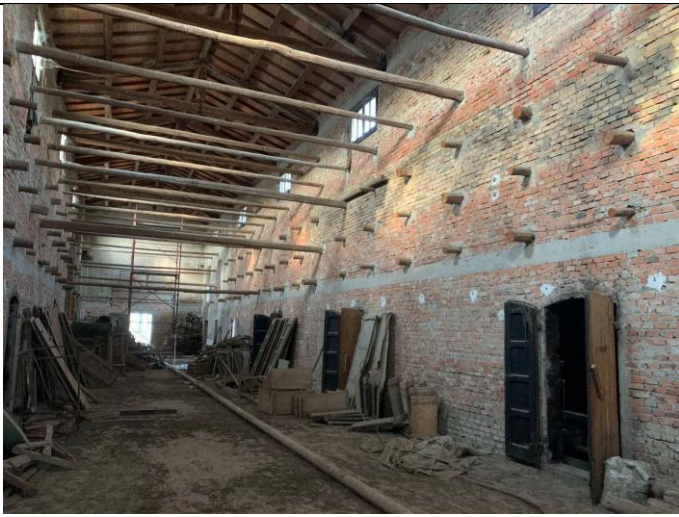
Vista della navata centrale al piano primo
