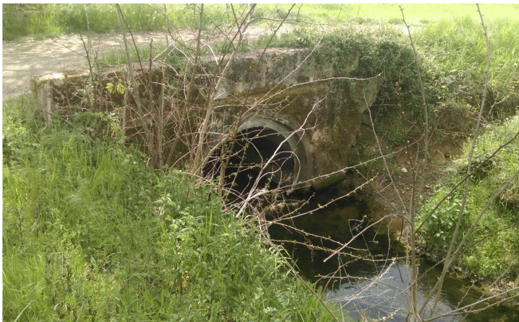
Figura 3: Tombatura della reglia dei mulini con diametro 1000mm in località Il Molinazzo
